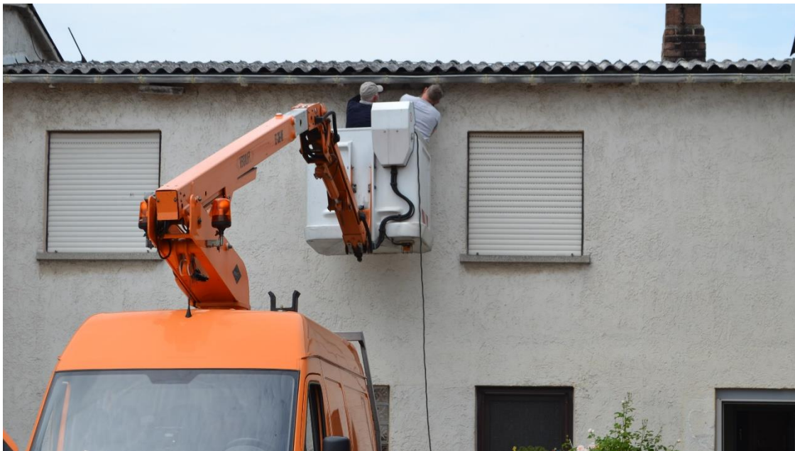
Mit einem Steiger lässt es sich leichter arbeiten
